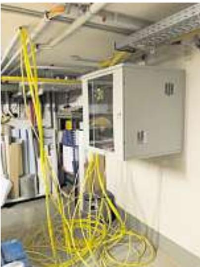
Dieser Tage wurde in der Kindertageseinrichtung St. Stefan Oberachern die Verkabelung für die neue Telefonanlage verlegt. Die Verkabelungsarbeiten wurden durch eine Elektrofirma durchgeführt. Die Installation der Telefonanlage erfolgte durch Mitarbeiter der Fachgruppe EDV der Stadt Achern. Für die Maßnahme sind 30.000 Euro im städtischen Haushalt eingestellt.
